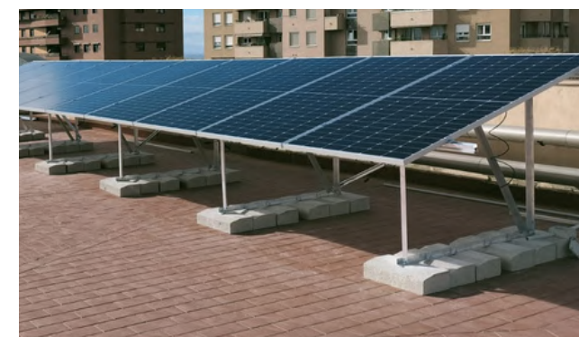
IS129 Anclaje lastrado, sobre bordillo
