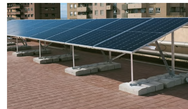
IS129 Anclaje lastrado, sobre bordillo
