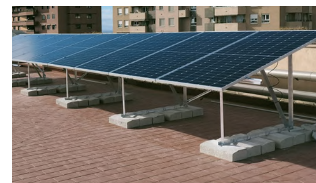
IS129 Anclaje lastrado, sobre bordillo
