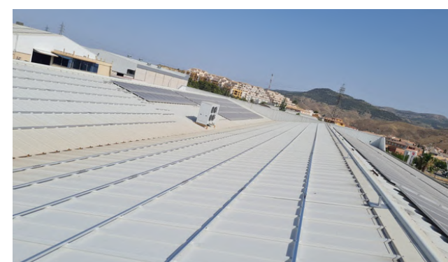
IS125 Anclaje sobre chapa, raíl de 41x41
