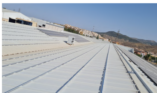
IS125 Anclaje sobre chapa, raíl de 41x41
