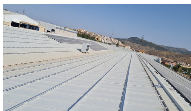
IS124 Anclaje sobre chapa, raíl de 38x60
