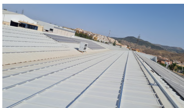
IS125 Anclaje sobre chapa, raíl de 41x41
